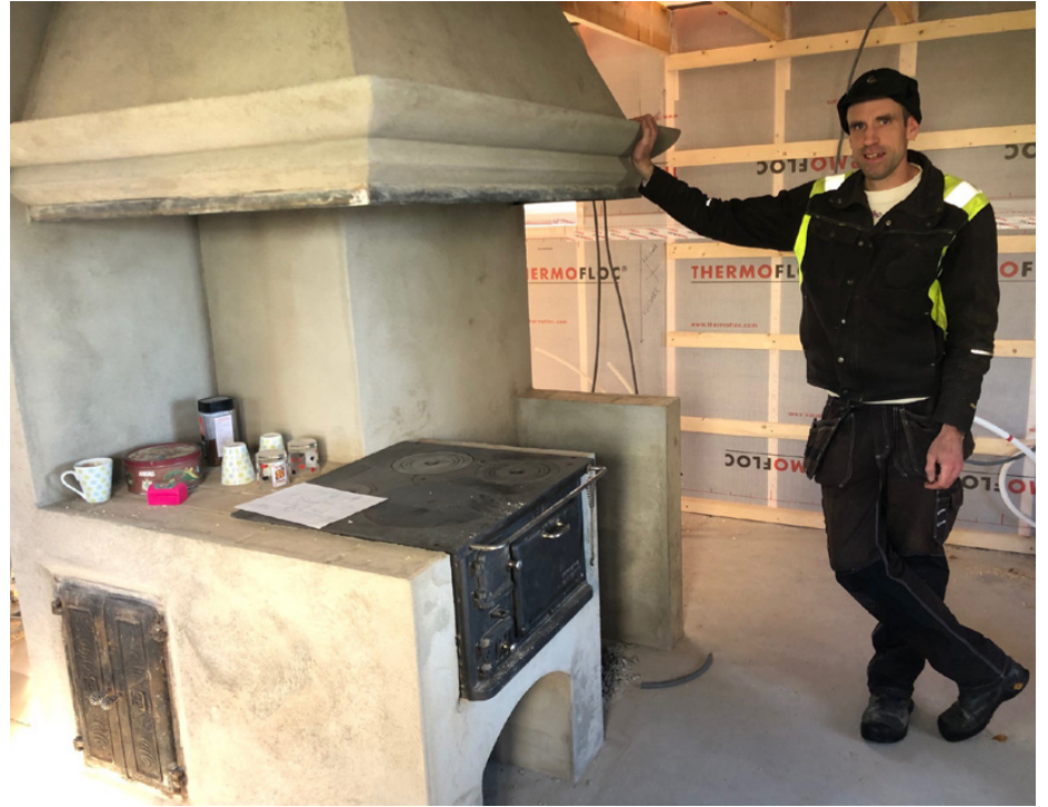
Husets stomme av timmerstockar är cirka 100 år gammalt. Invändigt är det dock frågan om en hel del nytt material, då det tagits hänsyn till gällande regelverk och krav.
