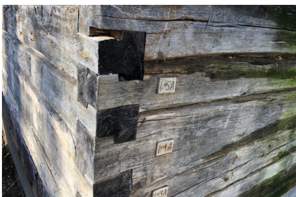
"Ett gigantiskt lego, men ett enkelt sådant", är Viktor Larsson omdöme om bygget av stommen. Var noga med numrering och dokumentation när du plockar ner huset, är hans råd.
